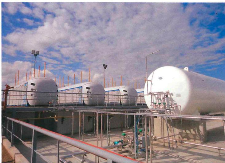
Nano Estaciones Cryobox™ de Producción de GNL capaces de convertir gas de boca de pozo en 15 toneladas diarias de gas natural licuado (GNL). Son totalmente relocalizables y tienen el mismo tamaño que un contenedor marítimo de 40 pies.
