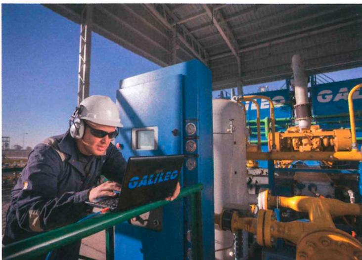
Compresión Distribuida: puesta en marcha de Compresores Galileo Process™ para boca de pozo en un pozo maduro operado por YPF en Loma La Lata, Argentina.
