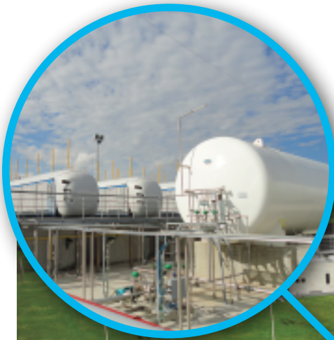
Cryobox® units and LNG storage
